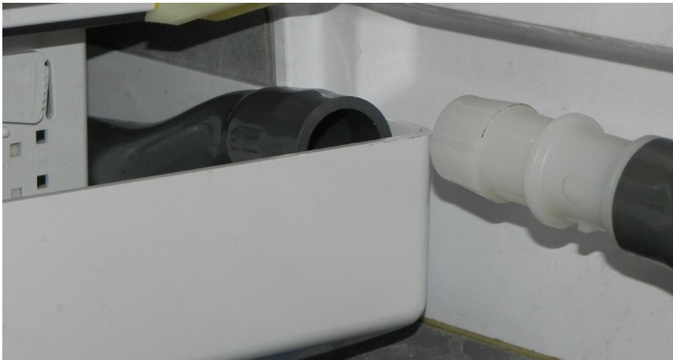
Desconecte el tubo de la bomba de agua como se muestra arriba y, luego, coloque la parte posterior de el tubo en el sumidero .
